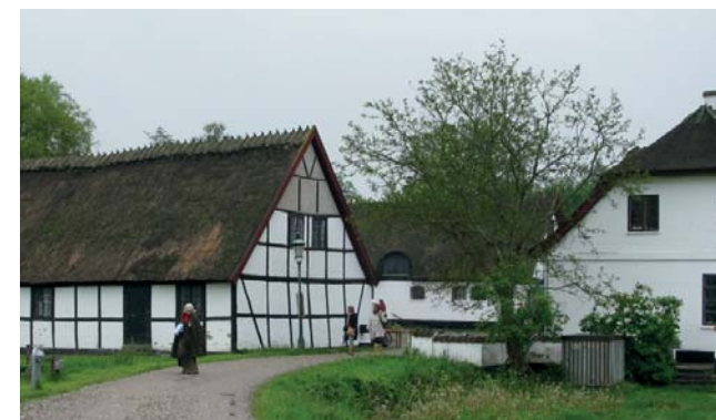
Som en historisk bondegård orientering omkring gårdrum Esrum Kloster, Arkitekt ukendt
